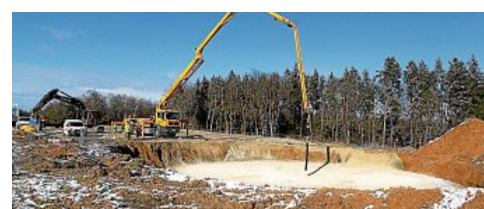
Baustelle in Gefahr: Noch dürfen die Arbeiten für die Windkraftanlage bei Johanneck weitergehen. Noch. BILD: GLEIXNER
